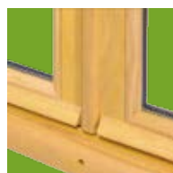
Battement extérieur avec jet d'eau assemblé et mouluré
