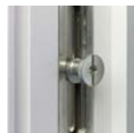
Galet anti-décrochement réglable en compression
