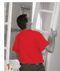
1. Dégondage des ouvrants.
