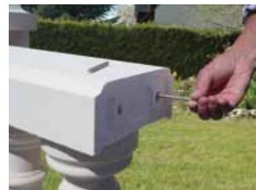
Mettre en place la lisse basse sur une assise de 2 à 6 cm de mortier et poser des balustres avec joints de 5 mm au mortier Weser-Mix JM. Sceller les clavettes entre lisses et trumeau.
