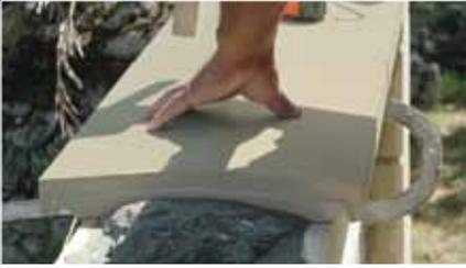
La pose des chaperons se fait sur lit de mortier selon les préconisations habituelles (voir fiche 1.05). À la pose du chaperon de départ, réaliser une coupe pour supprimer la partie femelle puis positionner l'extrémité mâle dans la direction du mur à couvrir.
