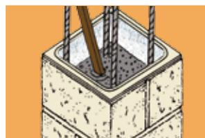
5. Remplir de béton maigre par couches successives de 75 cm (un seau de ciment pour 5 seaux de sable et gravier). Tasser à l'aide d'un bâton. En cas de coulures ou projections de mortier, nettoyer immédiatement à l'eau claire.
